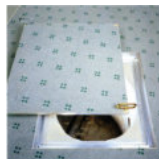
Eingebaut im Büro (Putzschacht), ausgelegt mit Teppich
