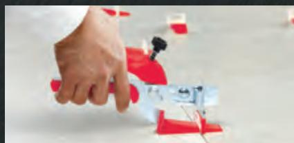
3. Entfernen der Keile nach 24 Stunden
